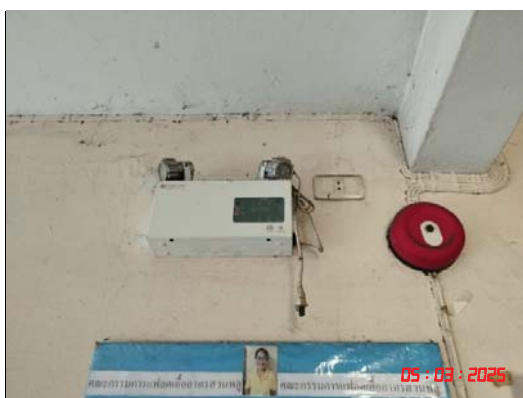
สัญญาณเตือนไฟไหม้และไฟฉุกเฉิน
